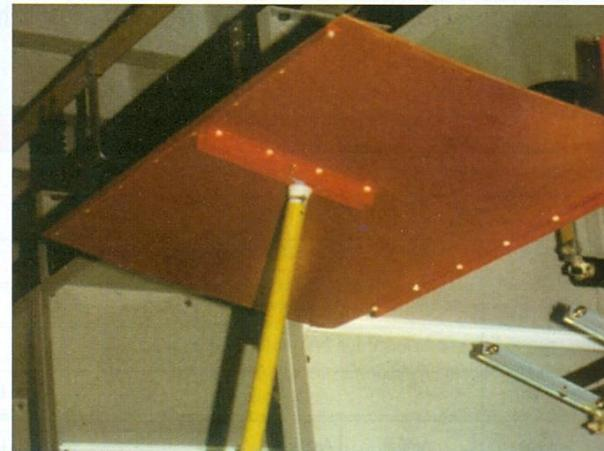
Einbringen einer isolierenden Schutzplatte der Bauform A3.
