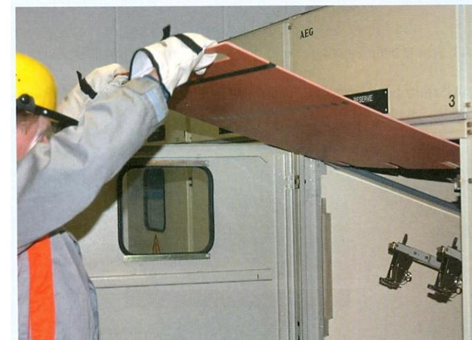
Einbringen einer isolierenden Schutzplatte der Bauform A1.
