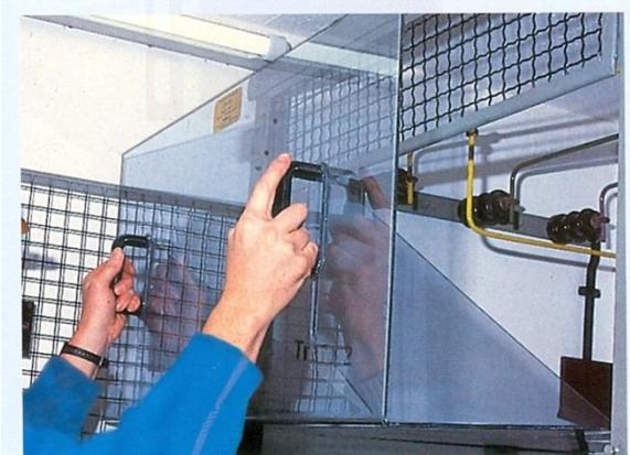
Einbringen einer isolierenden Schutzplatte (in durchsichtiger Ausführung) der Bauform A2.
